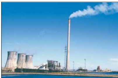
CENTRAL TÉRMICA DE CARBÓN
